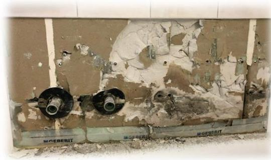
Einige Wandplatten wurden ersetzt, Kittfugen neu gezogen und die Zementfugen wurde neu gefüllt. So konnten wir die Unterhaltsarbeiten frühzeitig erkennen und weitere Schäden vermeiden.
