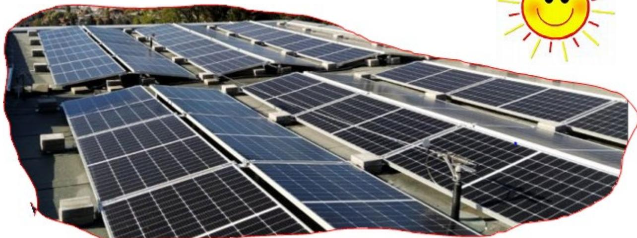
Von der neuen PV-Anlage auf den Dächern der Gebäude D – F. Damit die PV-Anlage montiert werden kann, wird das Kies auf den Dächern entfernt die Dächer gereinigt und einer Kontrolle unterzogen. Eine zusätzliche Schutzfolie wird die Dachisolation schützen. Anschliessend werden die Solarpanels aufgebaut und der Kies wieder auf den Dächern verteilt.
